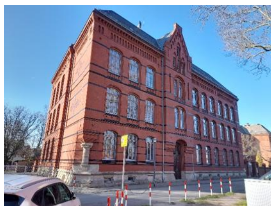
Abbildung 3: Saniertes Gebäude der Bergschule
