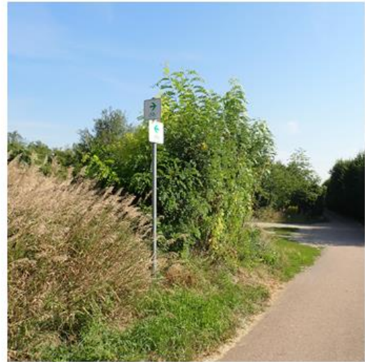
Zwischenwegweiser nach FGSV-Standard
