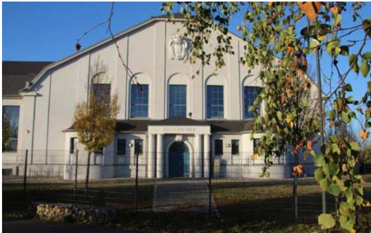
Abb. 20: saniertes Einzeldenkmal ehem. Heizwerk im Neustadt-Park
