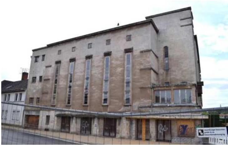
Abb. 19: noch unsaniertes Einzeldenkmal Gloria, ehem. Lichtspielhaus an der Merseburger Straße, Förderung mit Mitteln des Bundesprogramms „Nationale Projekte des Städtebaus“
