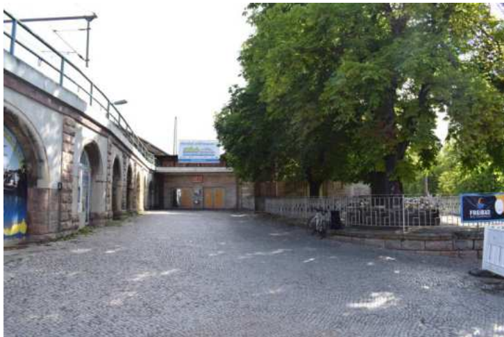
Abb. 46: Bestandssituation westlicher Bahnhofsvorplatz
