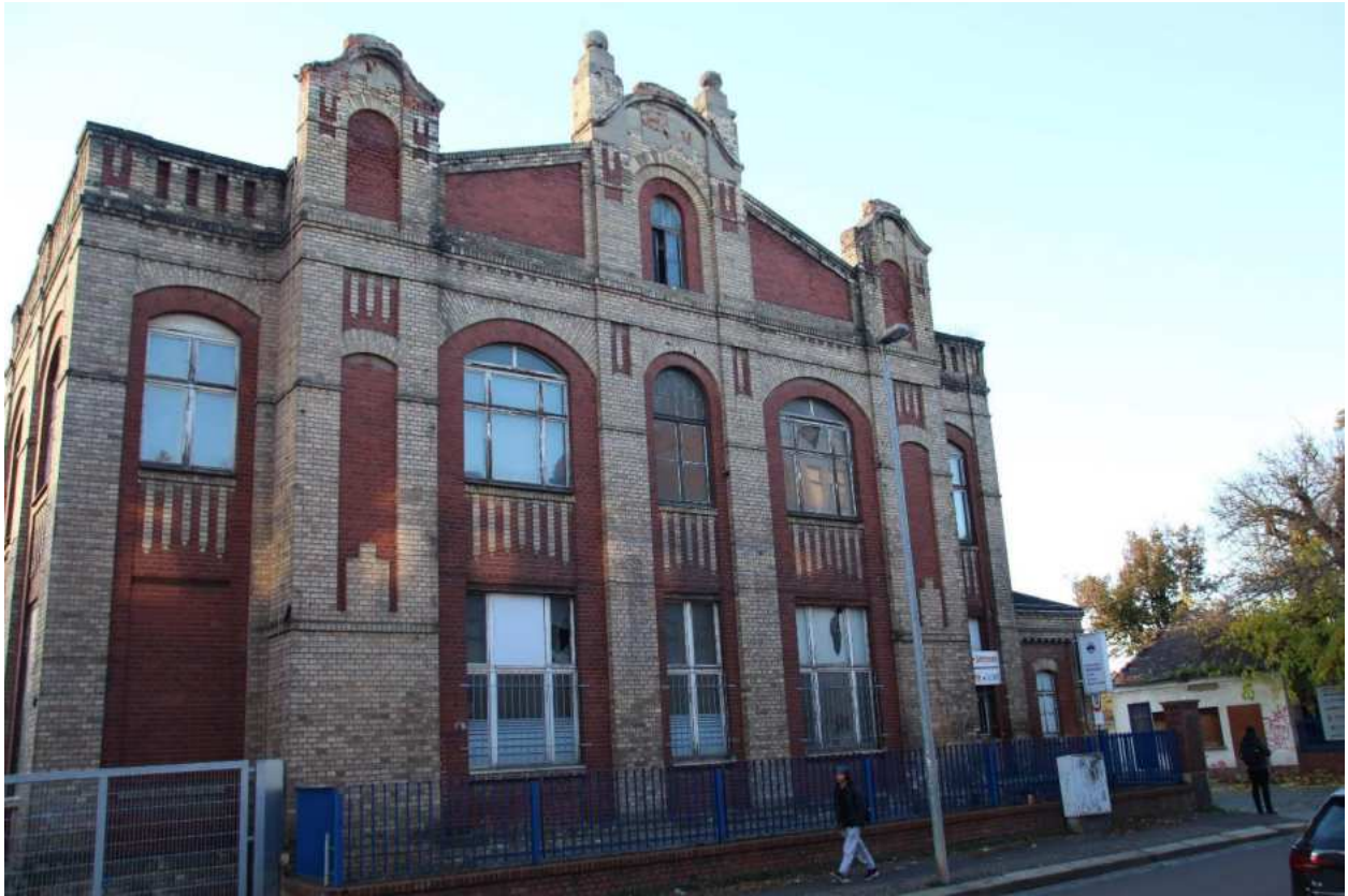
Abb. 91: gründerzeitliches Gewerbegebäude Tagewerbener Straße 33
